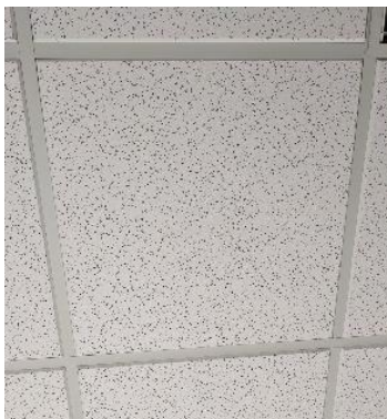
dalle de faux plafond
